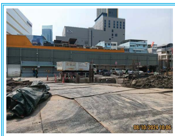
รูปที่ 3-3 รั้วชั่วคราวแบบ Metal Sheet สีเขียวไม่สะท้อนแสง สูงประมาณ 6.0 เมตร
