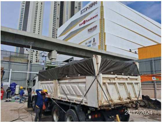
รูปที่ 3-18 รถบรรทุกขนส่งดิน และรถบรรทุกขนส่งวัสดุ ปิดคลุมด้วยผ้าใบทึบ
