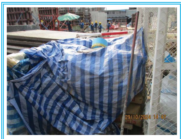
รูปที่ 3-25 คลุมผ้าใบบนกองถุงซีเมนต์
