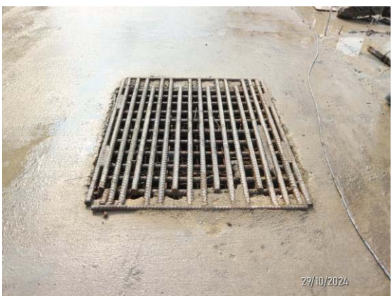
รูปที่ 3-20 ปอดักตะกอนดิน
