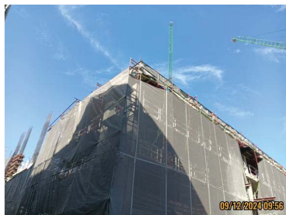
รูปที่ 3-21 ผ้าใบ Mesh Sheet คลุมอาคาร
