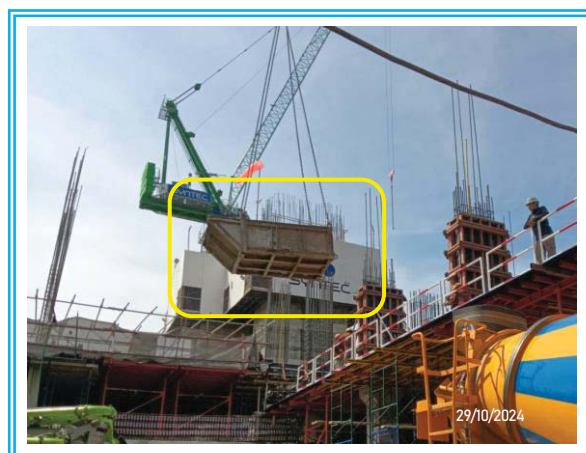
รูปที่ 3-26 กะบะสำหรับรวบรวมและขนย้ายเศษวัสดุ ก่อสร้าง
