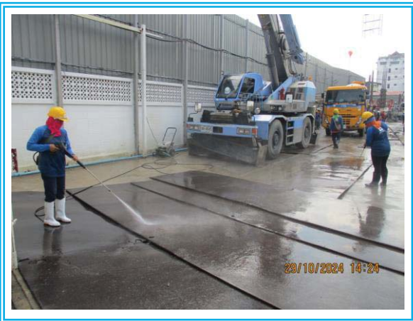
รูปที่ 3-30 พื้นที่ล้างล้อรถบรรทุกก่อนออกจากพื้นที่ โครงการ
